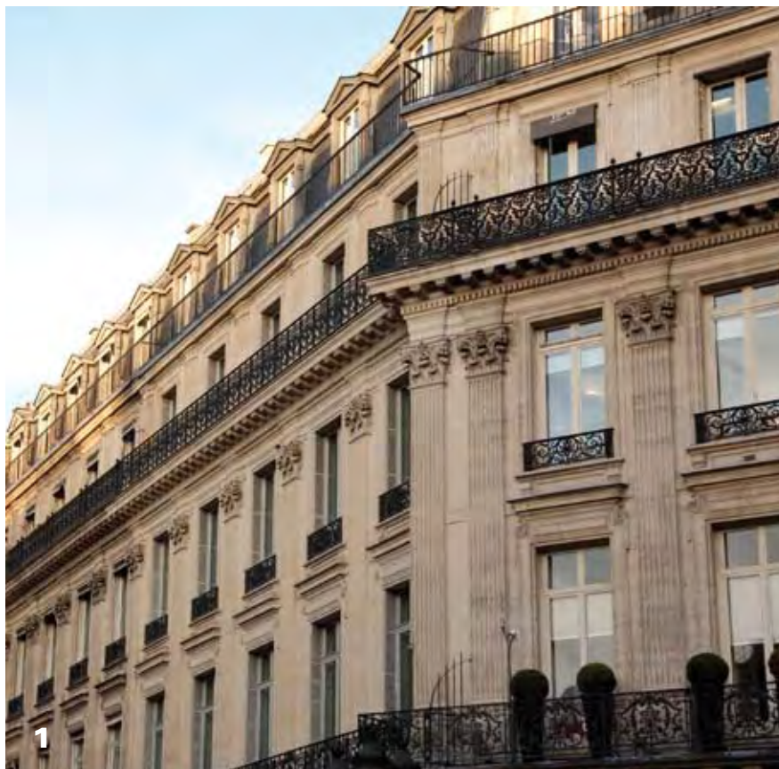
1-2-3| Evolution des ouvrants des immeubles de bureaux : type haussmannien (1), type mur rideau (2), type actuel avec retour des pleins (3) (Crédit photo : de Chalvron)
