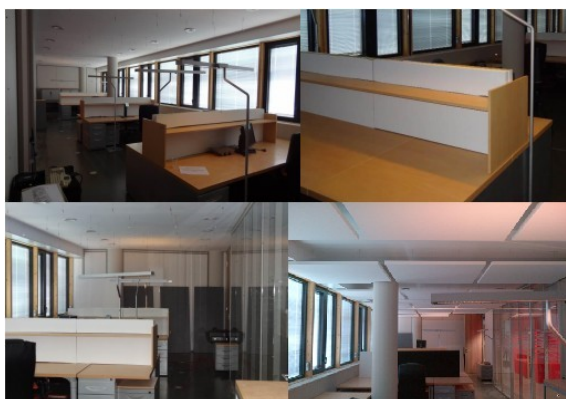
Photographie 2: en haut à gauche: Vue générale de l'espace paysager – taux de couverture du plafond 0%; en haut à droite : panneaux absorbants à base de laine de verre haute densité de 4 cm ; en bas à gauche : combinaison de deux panneaux absorbants contre le mur ; en bas à droite : unités suspendues - Ecophon Solo square. Longueur moyenne 13.7m, largeur moyenne 4.15m, hauteur sous dalle 2.78m. Surface 54m 2 , volume 150m 3 .
