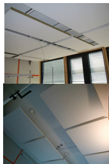
Photographie 3 – Panneaux de plafond couvrant 50% (gauche) et environ 70% (droite).
